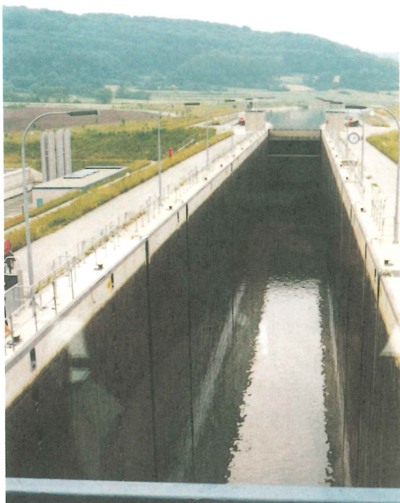
写－１ ベルヒング閘門
