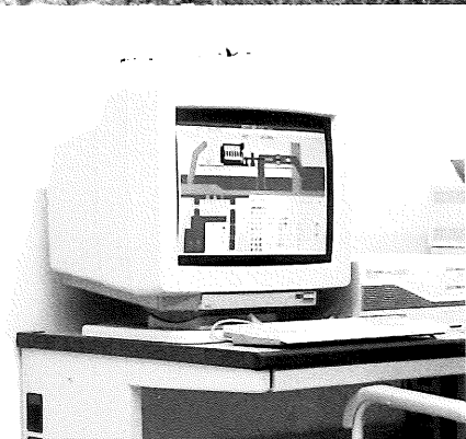
▲排水機場広域監視・制御システム
