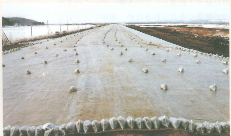
写一2 釧路沖地震、十勝川（豊頃町）の緊急復旧状況
