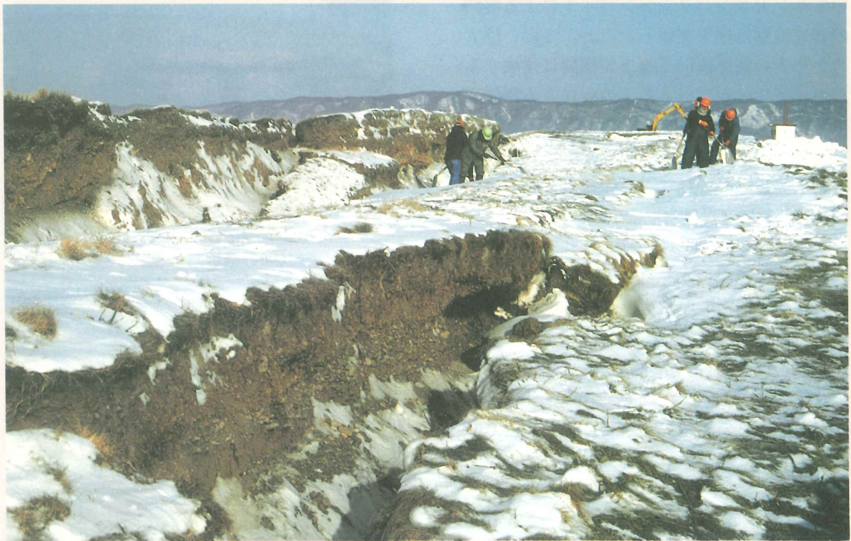
写一1 釧路沖地震、十勝川（幕別町）の被災状況
