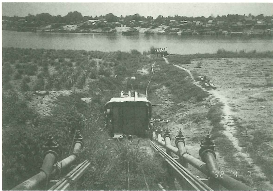
写一 昇降式ポンプハウス
