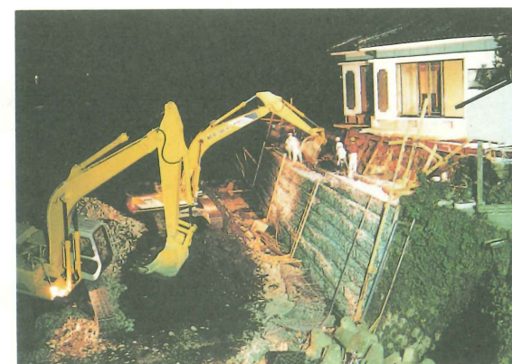
写一 4 川内川（8月豪雨、 鹿児島宮之城町）の緊急復旧状況
