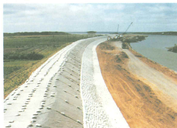
写一 2 北海道南西沖地震、後志利別川 （兜野築堤）の緊急復旧状況
