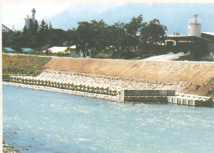
写一5 千曲川（梅雨前線、長野県松本市）の緊急復旧作業状況
