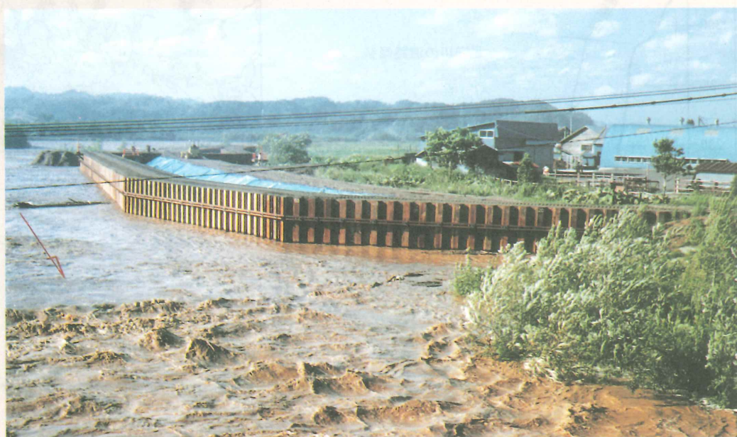
写一6 釧路沖地震、音別川（音別町）の仮締切と工事中の出水
