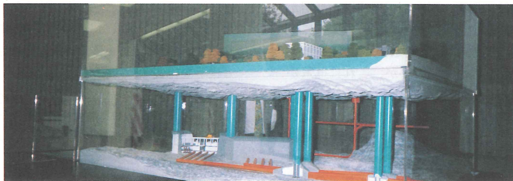
写ー5 シカゴ大深度ポンプ場のせり上がり模型
