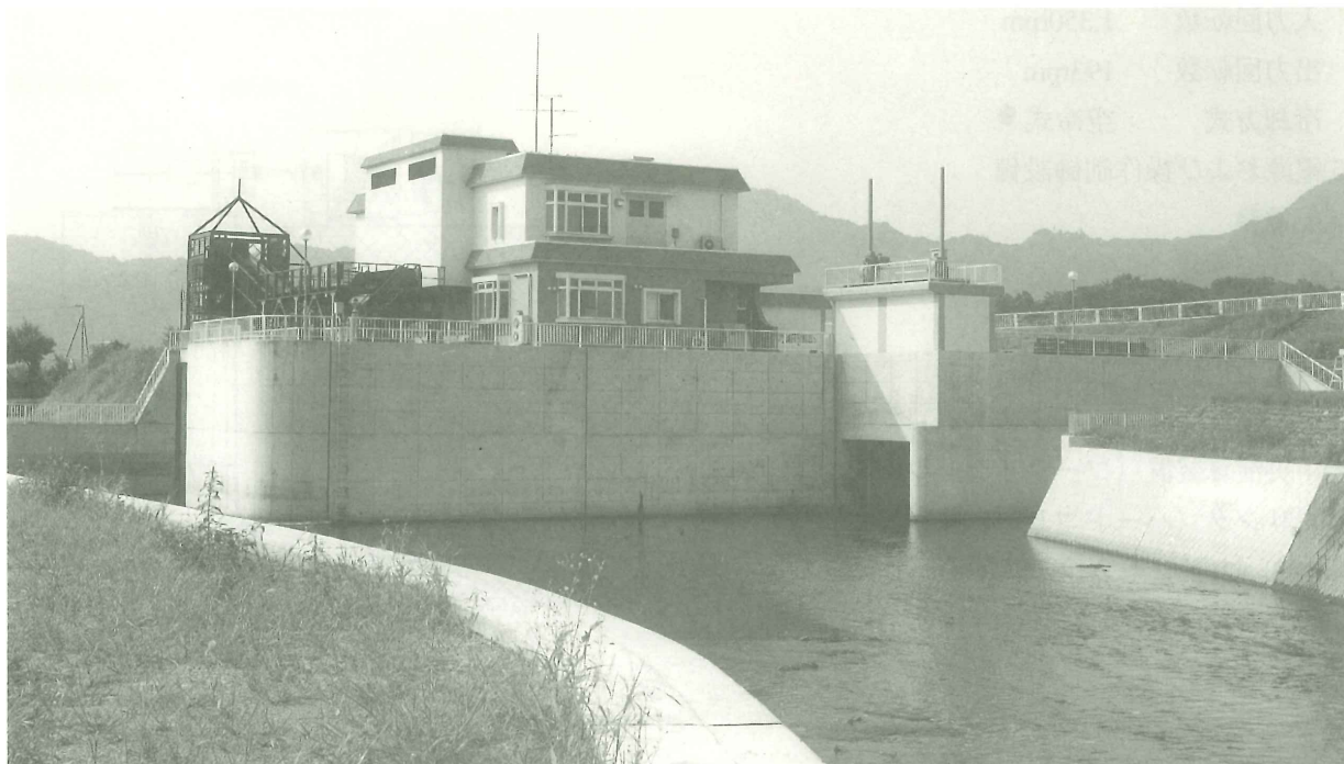
写－１ 境川排水機場全景
