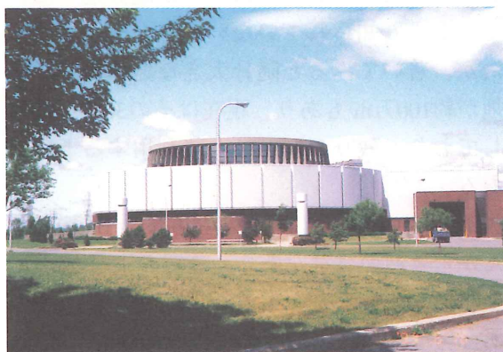
写－３ MUCポンプ場建屋
