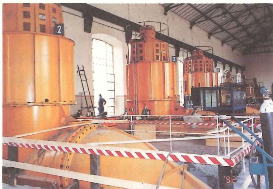
写-1 Codigoro P.S. 低水路用(改造中) イタリア 8\text{m}^3/\text{s} \times 6\text{m} \times 640\text{kW} \times 3 台 (立軸軸流可動翼) 9.5\text{m}^3/\text{s} \times 6\text{m} \times 665\text{kW} \times 4 台 (立軸斜流改造中)
