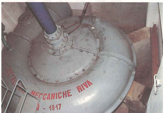
写-2 1917年製の立軸渦巻ポンプ (Codigoro P.S. イタリア)
