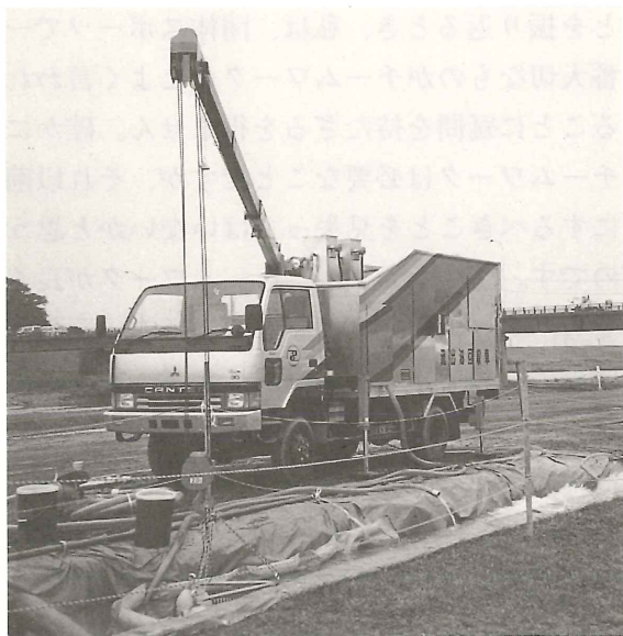
写－1 流出油回収車作業状況
