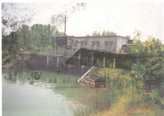
写-4 Brangues 水中ポンプ場 ( 17.2\text{m}^3/\text{s} ) ( 1,500\text{mm}\times 220\text{kW}\times 4 台 独プロイガー製 CNR フランス)
