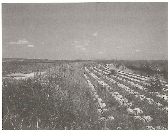
写-1 多自然型工法による護岸
