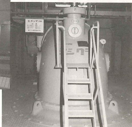
建設省関東地方建設局蓮花川排水機場 1500mm立軸斜流ポンプ
