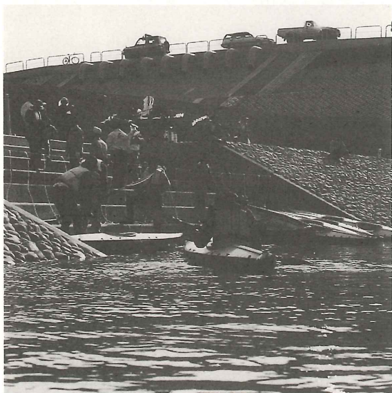
写－1 千曲川階段護岸
