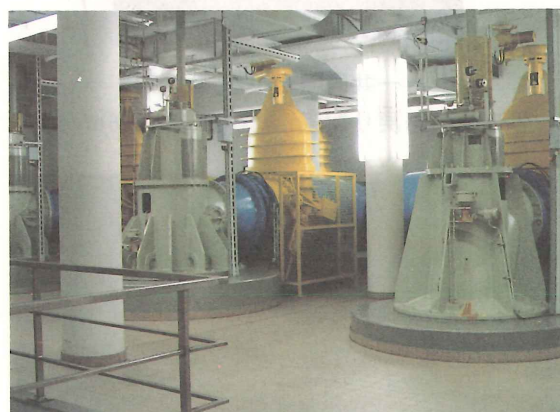
ルール水組合オーバーハウゼン中継ポンプ場 (ドイツ) 3.5\text{m}^3/\text{s} \times 14.5\text{m} \times 740\text{kW} \times 2 台他
