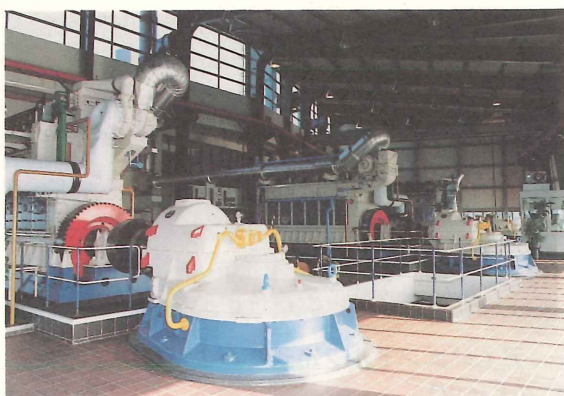
ブロック・ファン・クッフェラー排水機場 (オランダ) 14\text{m}^3/\text{s} \times 1200\text{ps} \times 4 台
