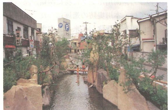
写－２ 二段河川の整備後
