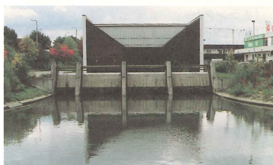
ディジェンドルフボーゲンバッハ排水機場 （ドイツ） 2 m 3 /s×6台 （吸水側より）
