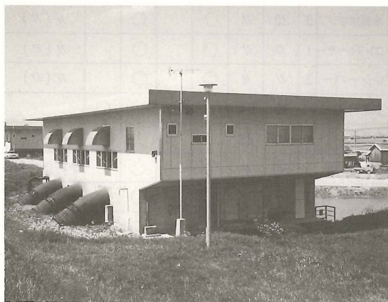
写－１ 機場建屋全景(改善後)
