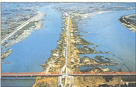
東海大橋付近の背割堤
