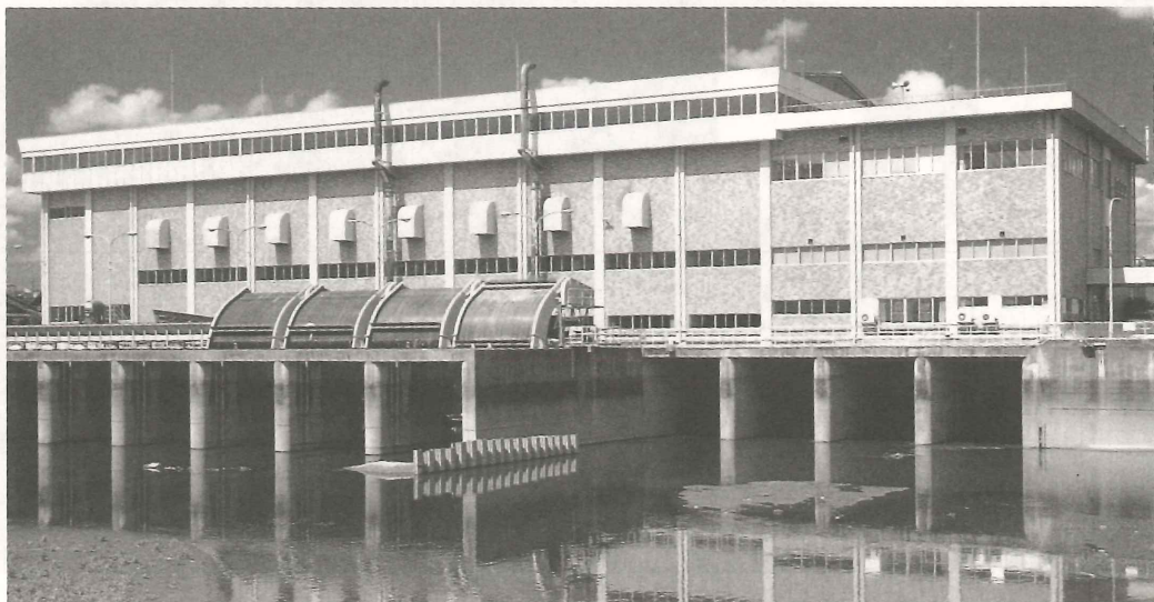
写-3 久御山排水機場概観
