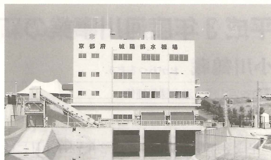
写－2 京都府城陽排水機場
