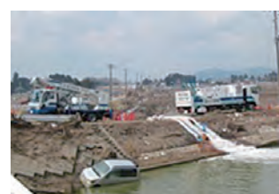
排水ポンプ車による排水活動
