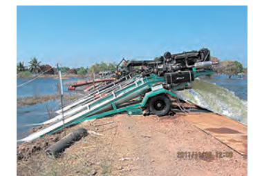
現地の移動式排水ポンプ
