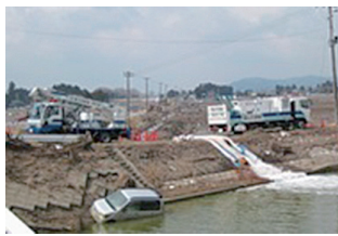
排水ポンプ車による排水活動
