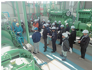
機器の運転管理
